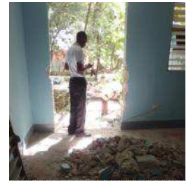
Atelier : perçement de la porte
