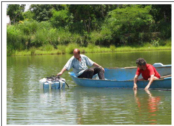
Pose de la prise d'eau flottante artisanale réalisée par Jean-Pierre et Daniel
