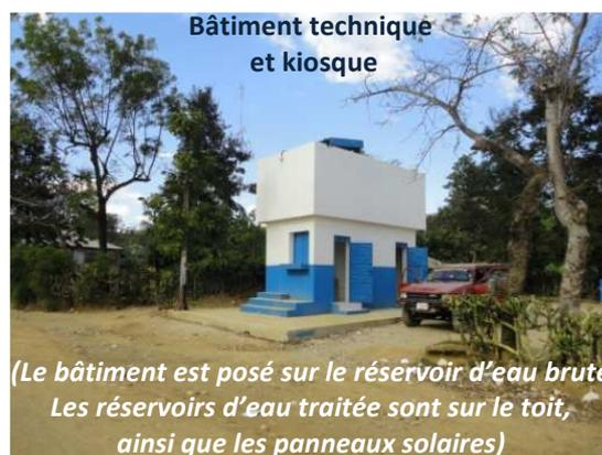
(Le bâtiment est posé sur le réservoir d'eau brute. Les réservoirs d'eau traitée sont sur le toit, ainsi que les panneaux solaires)
